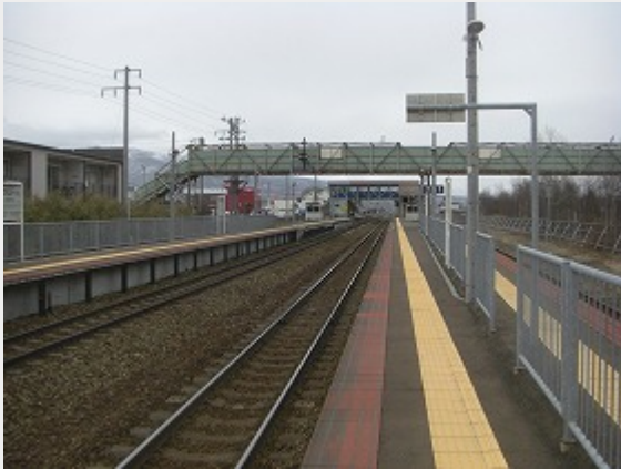
跨線橋から東室蘭方面を望む
