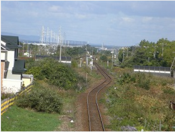
道道781号跨線橋から当駅を望む
