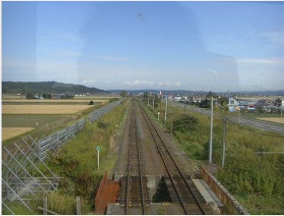
跨線橋から岩見沢方向を望む
